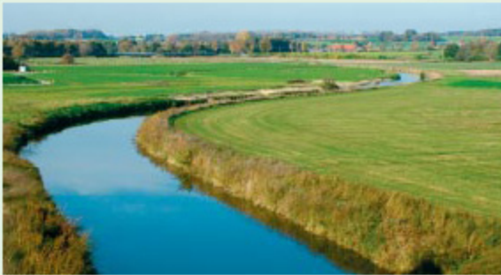
Blick von der alten Kanalbrücke: Die Befestigungen an der linken Uferseite (im Hintergrund) wurden entfernt. HG
